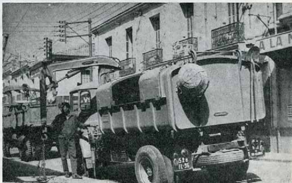
La Benne muni du bras TRACMA, va soulever le container enterré.
