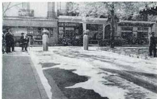
Après le passage de l'arroseuse la rue est recouverte d'une couche de Trepol
