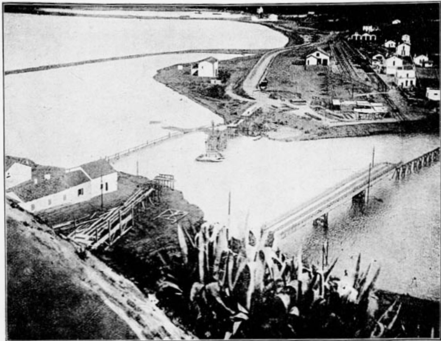
27. Les inondations de l'Oranie. — Ténès : à droite, le pont détruit et la passerelle pour conduite d'eau ; au centre, pont de pilots en construction ; à gauche, passerelle pour piétons.
