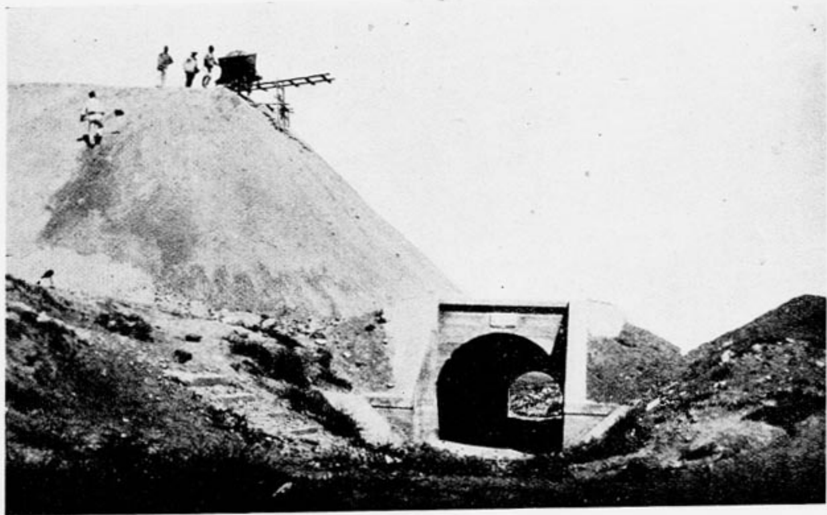
24. Ligne de Konif à Kalaa-Djerda. Remblai sur passage voûté.
