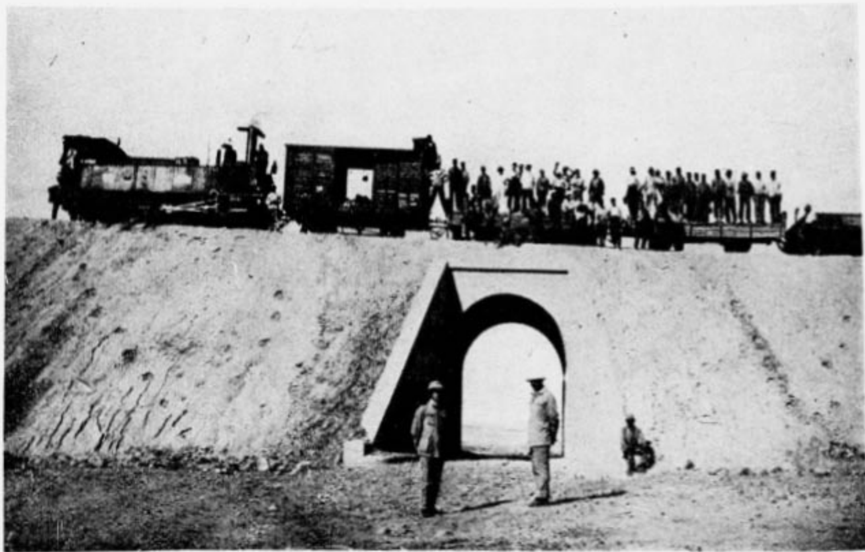
25. Ligne de Kouif à Kalaa-Djerda. Passage voûté et train de pose.
