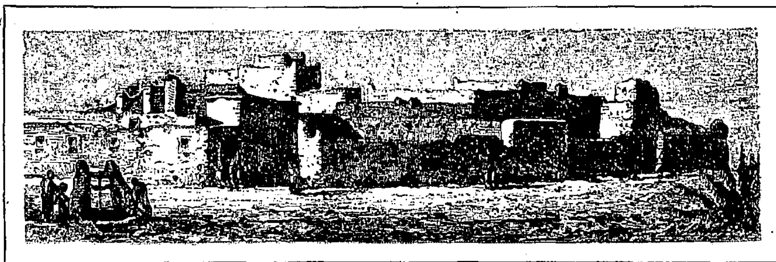
Entrée du Ksar Si Kadour à El Abiod.
