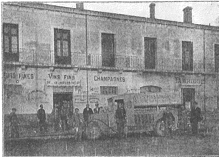
La Distillerie Ayribier : vue extérieure.
