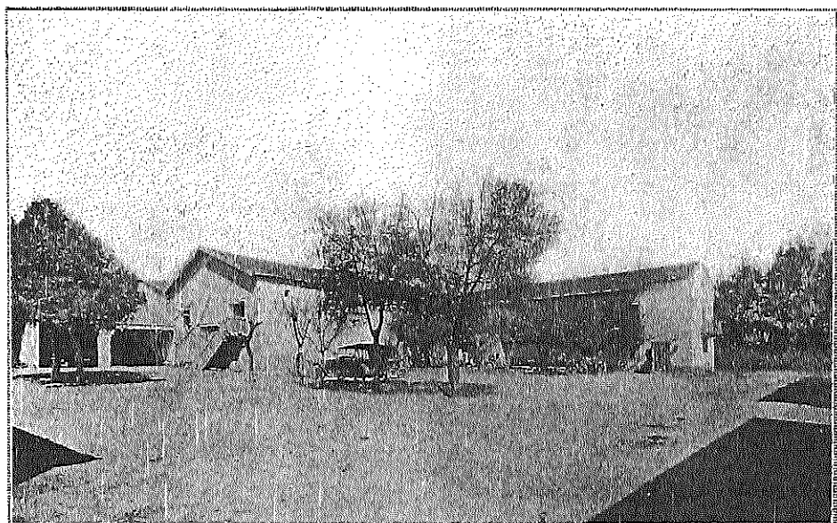
Maison d'habitation : Cave et cuverie.
