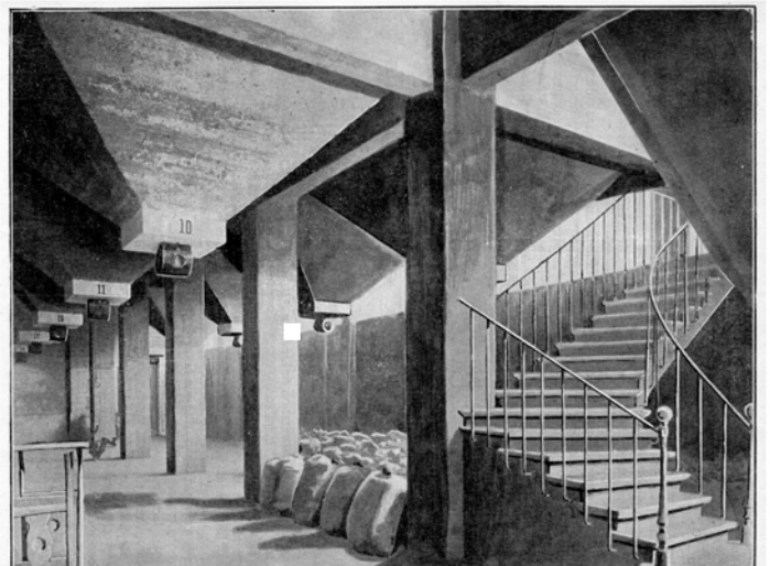
SILOS A GRAINS DE SIDI-BEL-ABBÈS Vue d'une rangée de trémies et de l'escalier d'accès.
