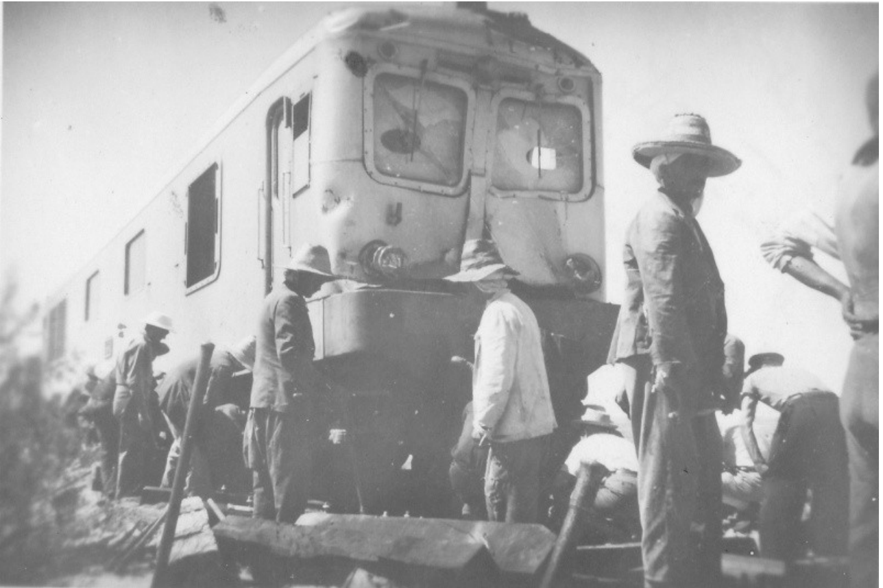
remise en état de la ligne
